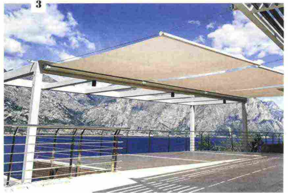
3. SCHERMATURA AUTOPORTANTE REALIZZATA SU PROGETTO (DI ANGELO FURIA) DA RESSTENDE . IL SISTEMA A RULLO MOTORIZZATO BOSTON, ABBINATO AL DISPOSITIVO DI TRAZIONE FORZATA TRACTION KIT EVO, CONSENTE LA COPERTURA VERTICALE E ORIZZONTALE DI AMPIE AREE E ALTA RESISTENZA IN PRESENZA DI FORTI VENTI. 4. TOKU , DI VINCENT VAN DUYSSEN PER PAOLA LENTI . STRUTTURA OMBREGGIANTE IN MASSELLO DI CEDRO TRATTATO CON IMPREGNANTE NATURALE TRASPARENTE. DISPONE DI QUATTRO PANNELLI DI BASE, DUE FISSI E DUE CON SCHIENALE REGOLABILE, COMPONIBILI SECONDO NECESSITÀ. IMBOTTITI E RIVESTITI IN WARA, UN NUOVO TESSUTO OUTDOOR CHE RICHIAMA LA PAGLIA. IL SISTEMA SI COMPLETA DI TENDE SCORREVOLI VERTICALI IN TESSUTO THUIA.
